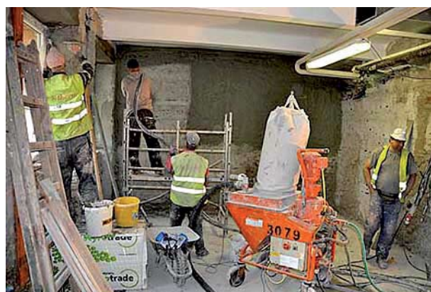
Modernizace školní jídelny...
