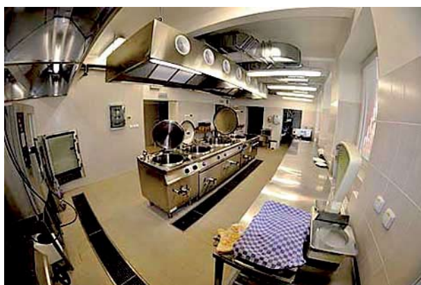
Modernizace školní jídelny...
